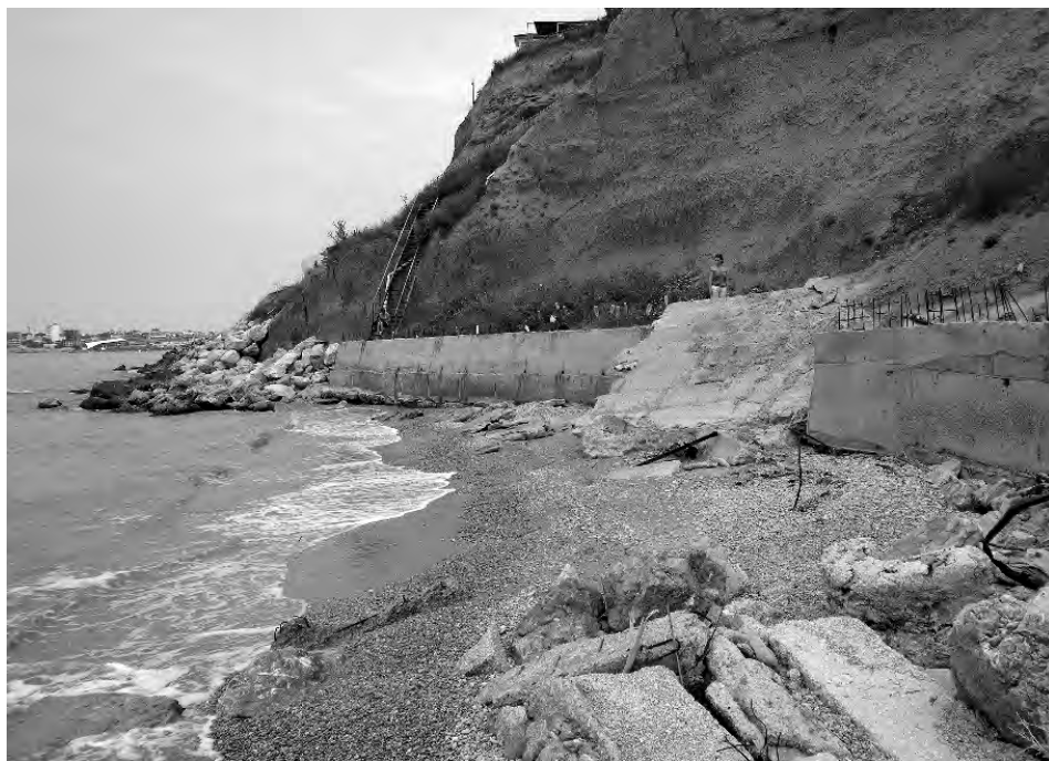
Рис. 1. Берегозащитные сооружения СТ «Мираж» не стабилизируют клиф, но вызывают размыв пляжа и его замусоривание. В центре – обвалившийся крупный обломок стены здания, стоявшего на бровке клифа
